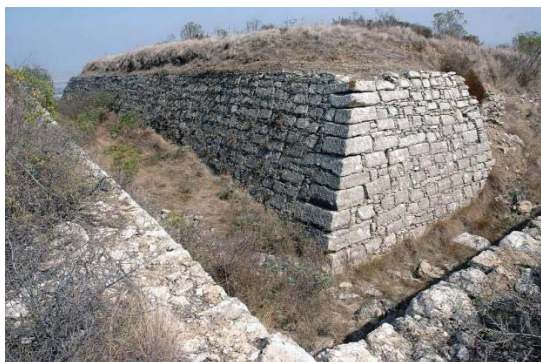
Fortificações das Linhas de Torres Vedras - Agueira
