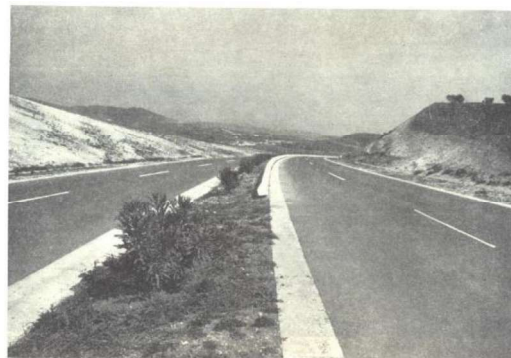
Aspecto da Auto-Estrada em Vialonga
