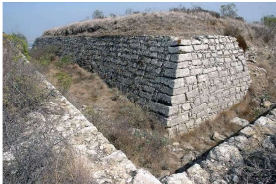
Fortificações das Linhas de Torres Vedras - Agueira
