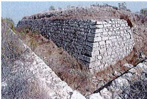
Fortificações das Linhas de Torres Vedras - Agueira
