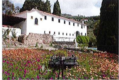
Convento de Nossa Senhora do Amparo
